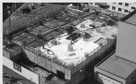
平成29年9月21日 2階床 コンクリート打設
