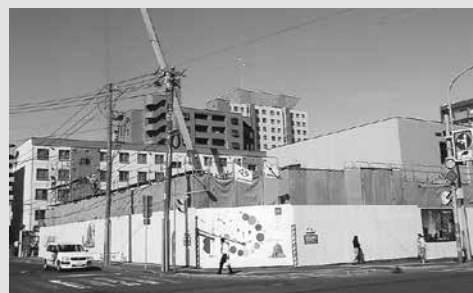
平成29年9月20日 工事現場外見
