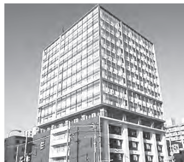
サービス付き高齢者向け住宅 イリス北10条 札幌市東区北10条東7丁目1-30
